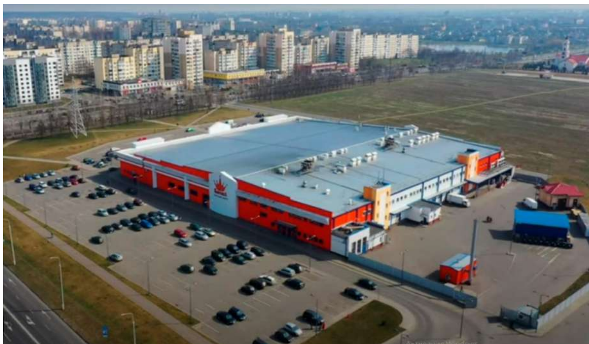
Торговый центр на пересечении улиц Доменикана и Советский проспект
