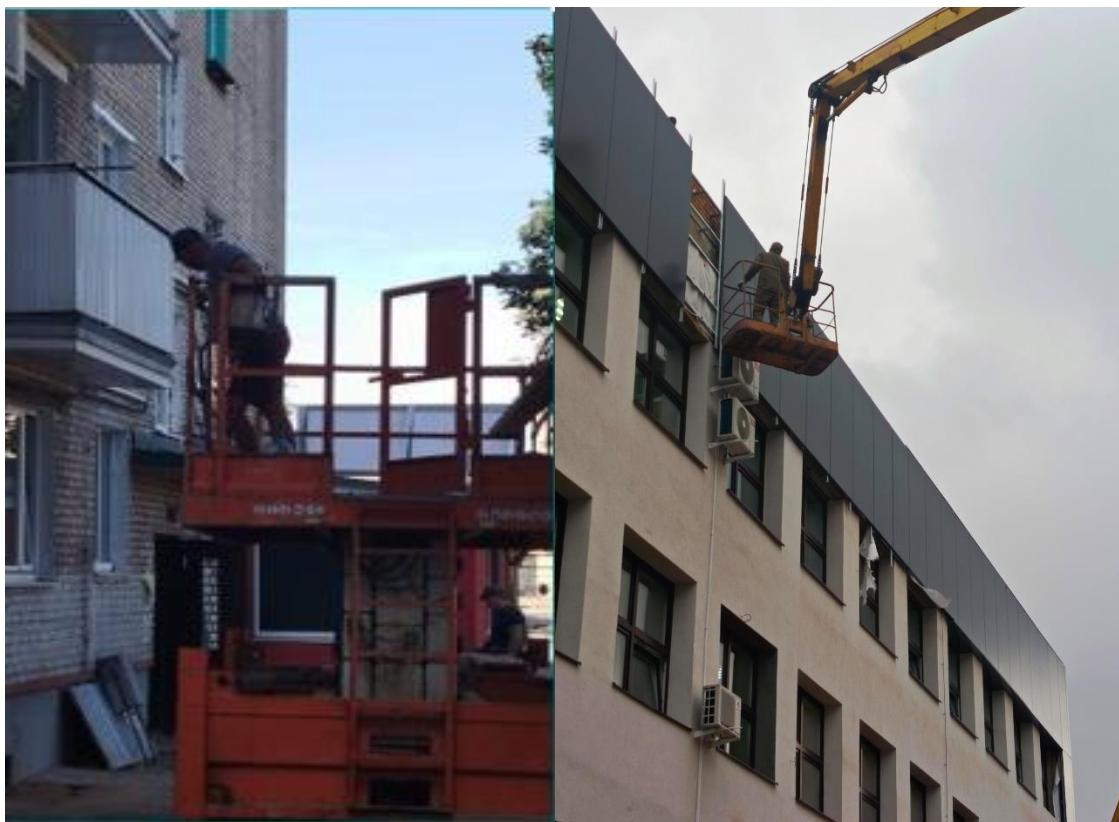
*Работники допущены к выполнению работ без применения средств индивидуальной защиты, непосредственно обеспечивающих безопасность труда (защитные каски, предохранительные пояса).*
