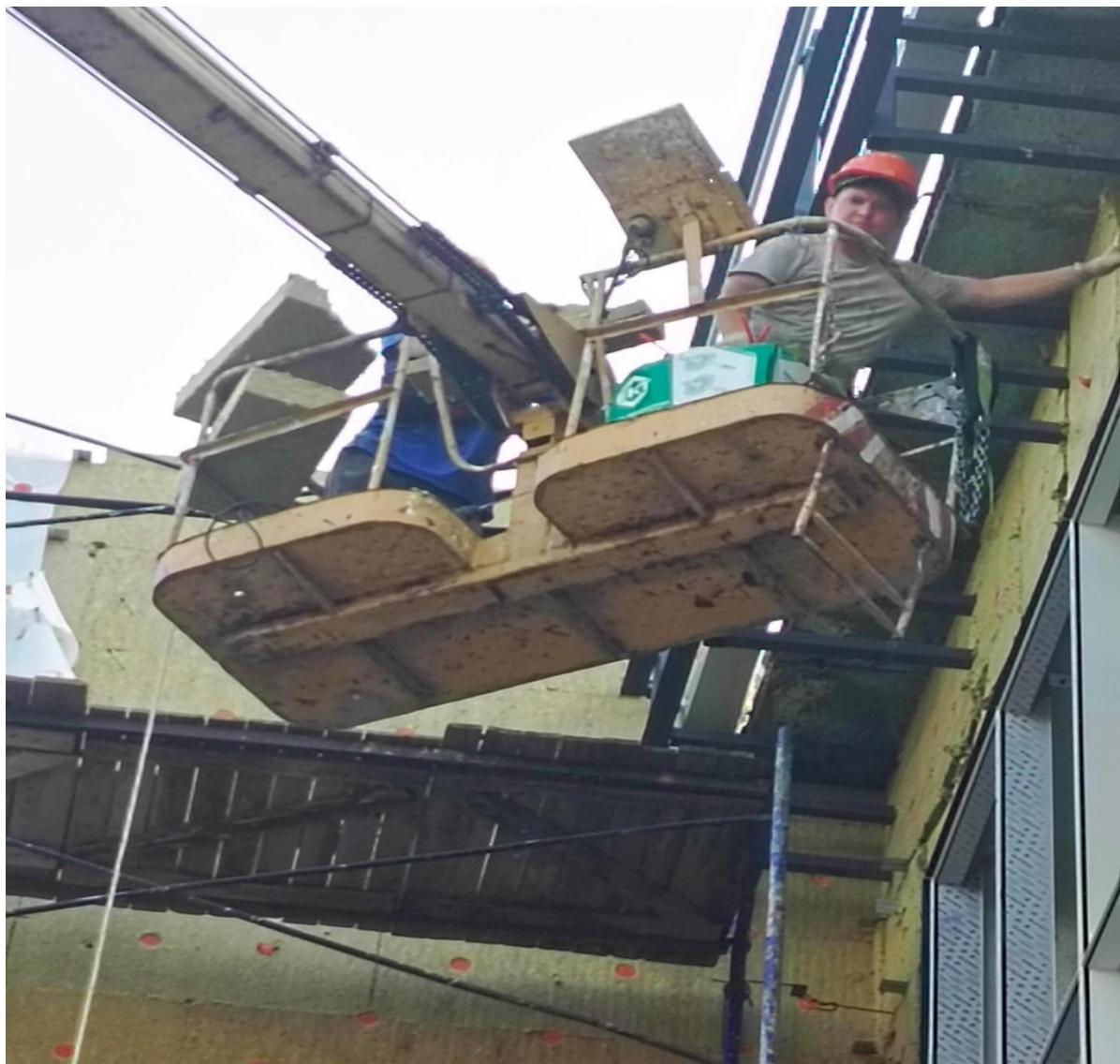
Строительные материалы размещены непосредственно на ограждении платформы.
