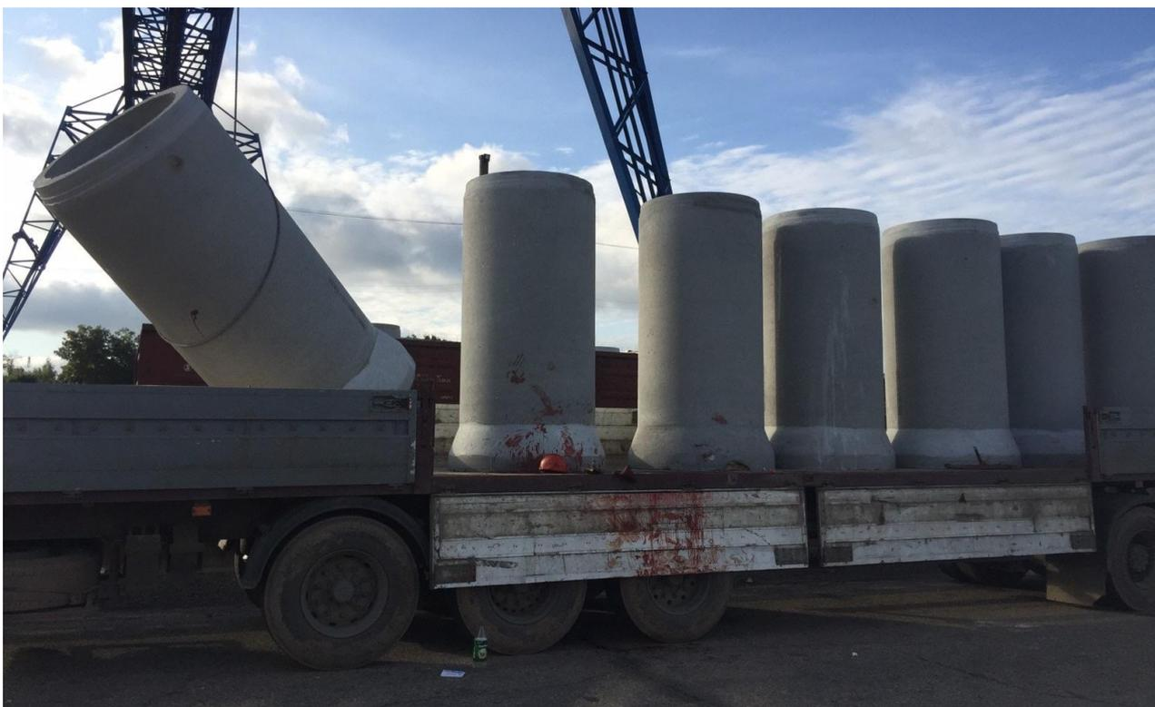
Травмирование стропальщика произошло при выполнении разгрузочно-погрузочных работ с применением консольно-козлового крана, зарегистрированного в Витебском областном управлении Госпромнадзора. При погрузке железобетонных труб в автотранспортное средство пострадавший, находясь в кузове автомобиля, осуществлял ручную выравнивание подвешенного к крюку грузоподъемного крана груза и его установку. Вследствие внезапного разворота подвешенной
