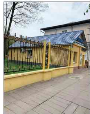
Фасад со стороны парка до реконструкции
